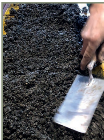
Stesura impasto isolante
