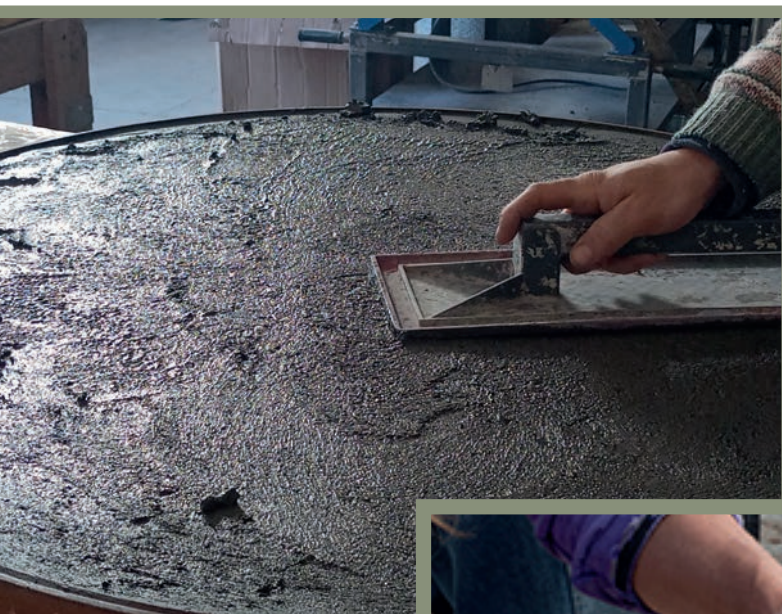
Applicazione della finitura in calce color antracite
