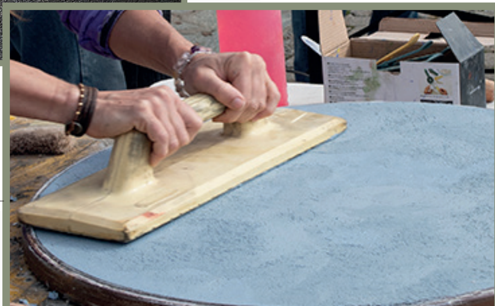
Applicazione della finitura in calce color azzurro
