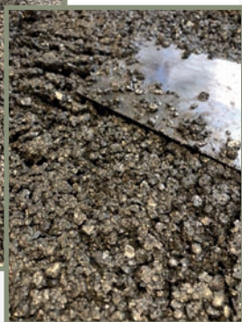
Stesura impasto refrattario e posa filo resistenza
