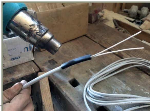
Isolamento collegamenti elettrici
